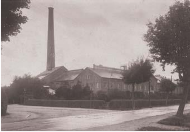
Foto: Sukkerfabrikkens ældste dele er opført i 1884, bl.a. hovedbygningen med den flotte sandstensportal. Arkitekten bag byggeriet er L. Fenger.
