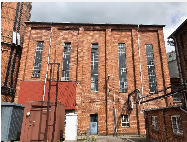
Kedelhuset samt parti fra skorstenen
