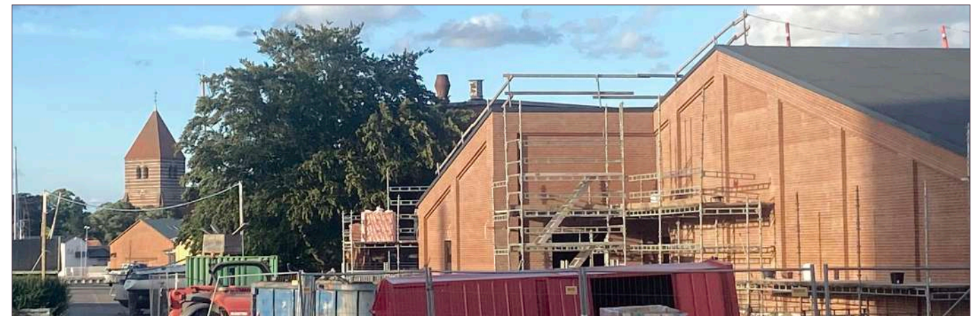
Etablering af nye detailbygninger juli 2022
